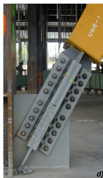
Figura 5. (a) Structură metalică la care s-au folosit BRB; (b), (c), (d) moduri de prindere a BRB de gusee
